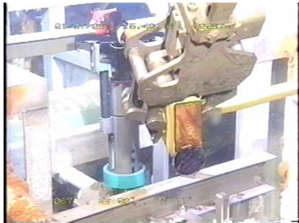
写真4 水中着脱式光コネクタの接続
