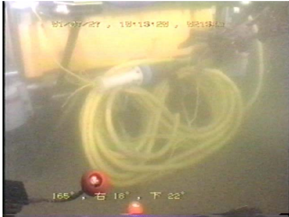
写真5 ジョイントマックスー観測装置間のケーブル展張と接続
