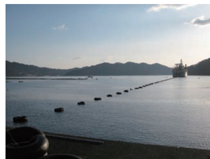
ケーブル敷設の様子
