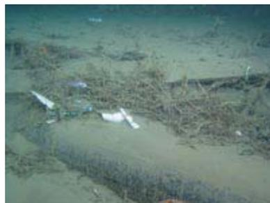
ハイパードルフィンが写した海底の様子。深層水施設の取水管(写真)が本来の設置位置(緑線)から南東方向(青線)にずれている。
