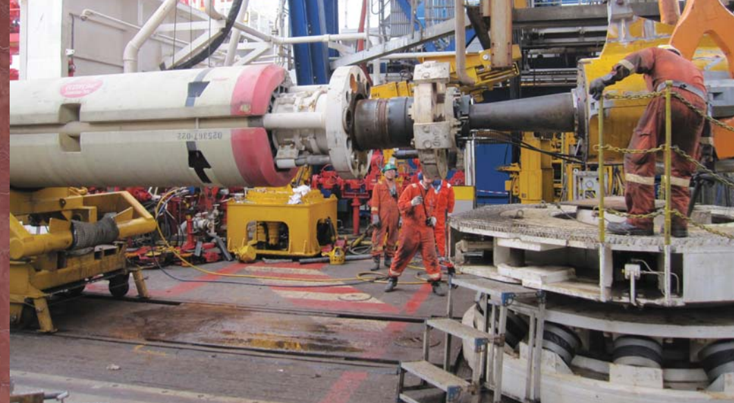
▲ライザーパイプを降下する作業の様子
