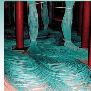
計算機フロアの床下スペースに敷設された各ノード間を接続する大量のネットワークケーブル。総本数8万3,200本、総延長約2,400kmに及ぶ。
