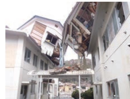
被災直後の女川フィールドセンターの様子。津波により流出した民家がセンター2棟の屋根に乗り上げた。同センターは研究実験棟・職員宿舎などの施設が全壊し、研究機器やデータなどすべてが失われた。撮影：鈴木善幸
