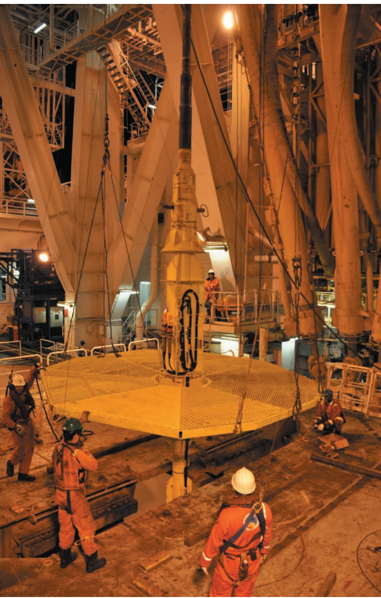
長期孔内観測システムが設置された掘削孔の孔口部に置かれるプラットフォーム（直径約5m）とDONETに接続するためのコネクタ部を「ちきゅう」船上で準備の様子。
