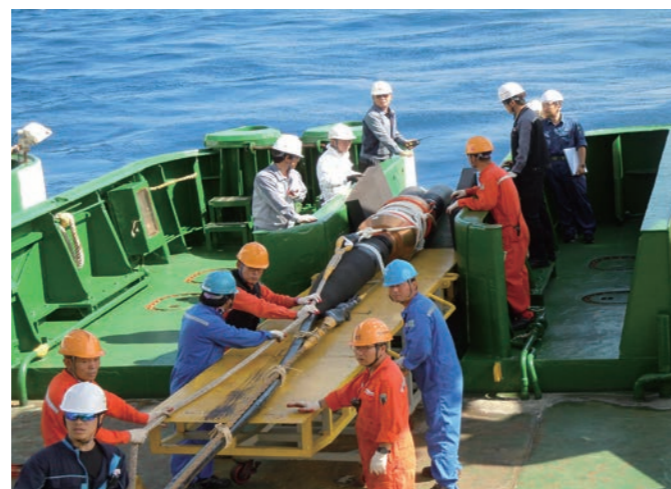
分岐装置の設置作業。
