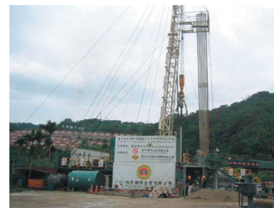
チェルンプ断層の掘削の様子。
