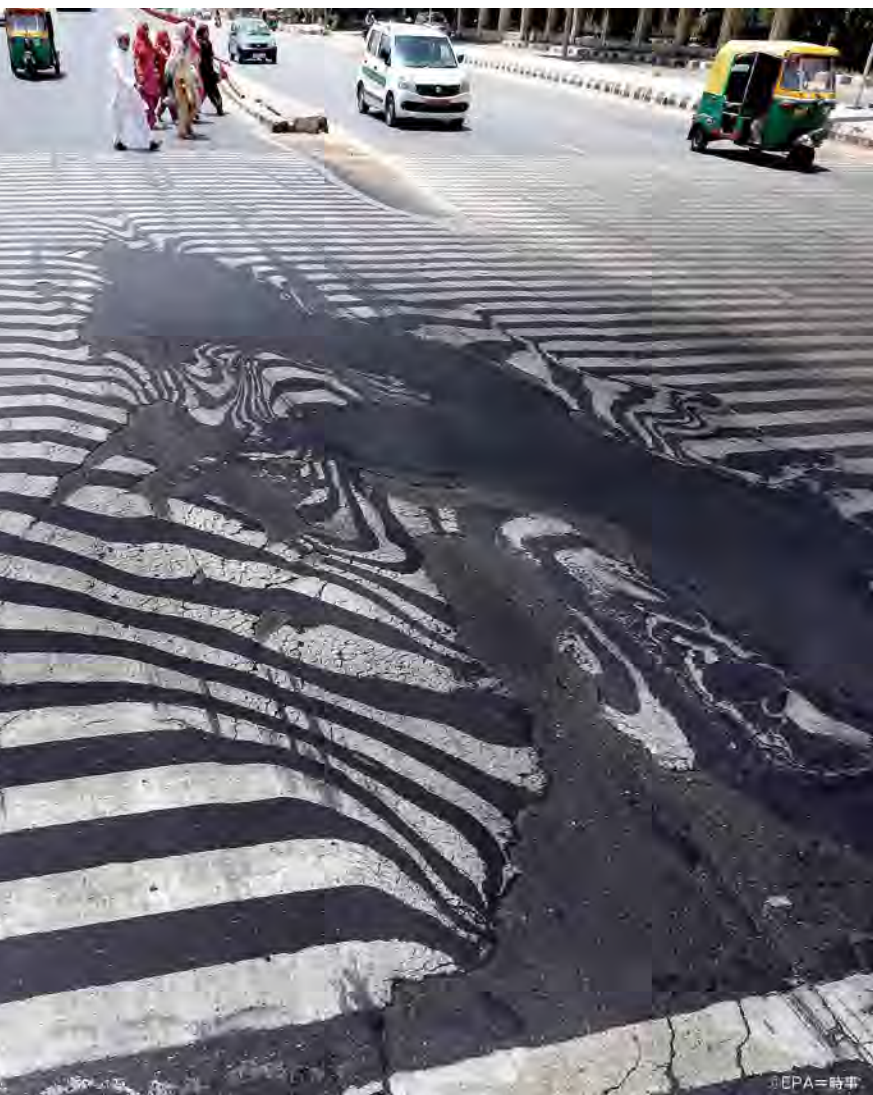
2015年5月に発生した熱波の際、暑さのためにゆがんでしまった道路。インド・ニューデリーで撮影された写真である。©EPA=時事
