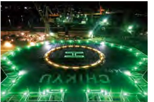
2017年の中間検査にて、ヘリデッキ改修後の点灯試験の様子。国際規格に適合するように改修を行った。
