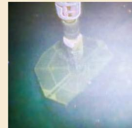
C0006において長期孔内観測システムの設置を終え、掘削孔の最上部に孔口装置を取り付けている様子。無人探査機による撮影。
