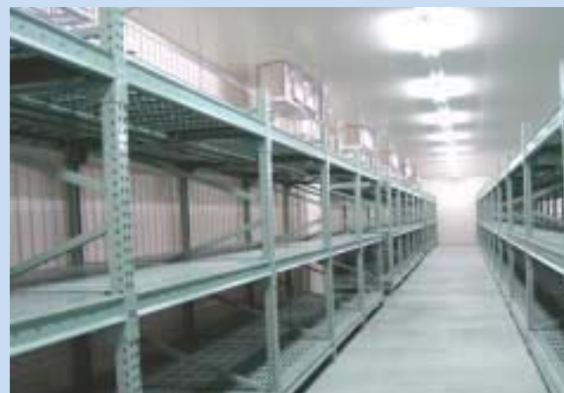
掘削された海洋コア試料を保管するコア冷蔵保管庫。4室ある冷蔵保管庫は、それぞれ個別に温度管理することができる。
