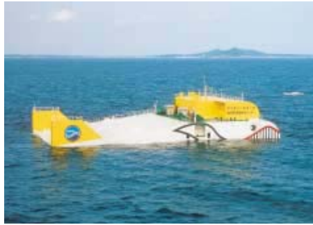
マイティールホーエル波力発電装置 1998年から三重県度会郡南勢町（現・三重県度会郡南伊勢町）五ヶ所湾湾口沖合に設置。実用化を目指したプロトタイプとして発電実験を行った
