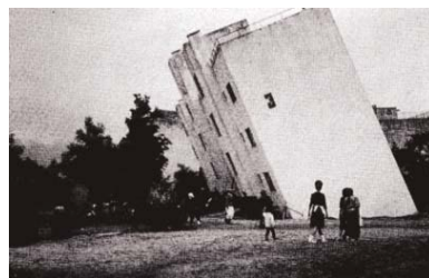
図1 液状化によって傾いたアパート
