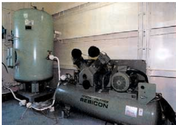
写真3 空気圧縮機 Photo 3 Air compressor
