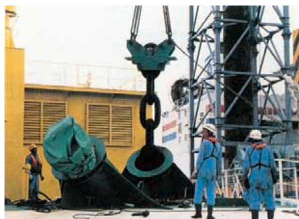
写真 9 根止め作業 Photo 9 Chain stopping work
