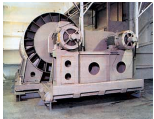
写真2 NO.1タービン・発電機システム (50kW + 10kW) Photo 2 No. 1 turbine and generator system (50kW + 10kW)
