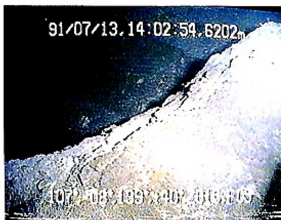
写真7 上部斜面のトラフ状の溝の側面に発達する亀裂 Photo 7 Cracks at the wall of a trough at the upper slope.
