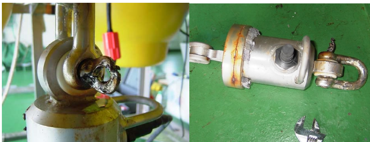
図 4 切り離し装置を吊り下げていたシャックルの腐食。
