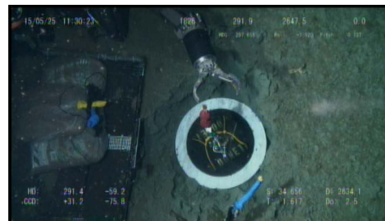
(d) Placing a cover plate on the caisson
