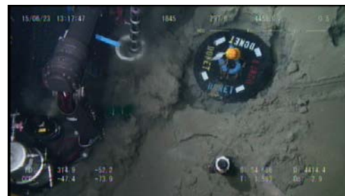
(d) Placing a covering plate on the caisson
