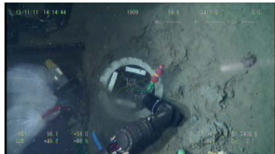
(d) Placing a cover plate on the caisson
