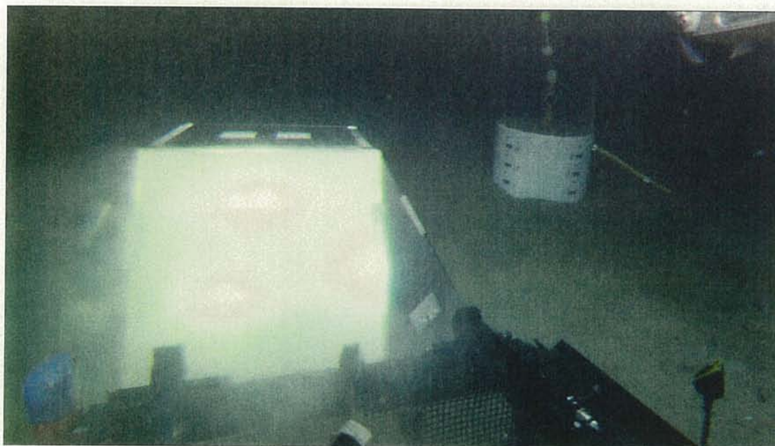
図1 地震計カバーの設置準備（右後方は既設カバー）
