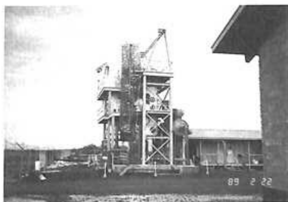
写真-1 NELHにおけるオープン・サイクル式海洋温度差発電の実験装置
