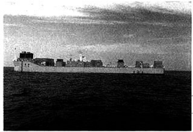
写真-2 波力発電装置「海明」
