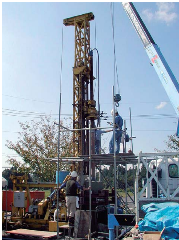
図6 掘削マシンによる制菌コアバーレル評価実験
