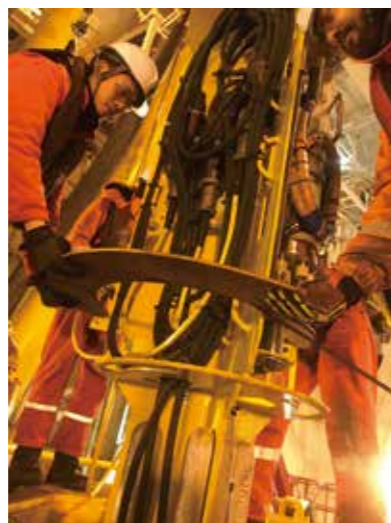
図1：孔口装置(LTBMSの海底面より上の部分)の準備作業。掘削した孔にLTBMSを挿入し、セメントで固定した後、掘削孔の最上部に孔口装置を設置します。この孔口装置にDONETの海底ケーブルを接続します。
