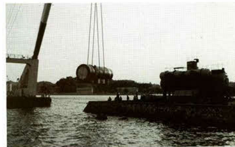
■わが国初の高圧実験水槽、本体の積み降し、当センター内に設置された—本体は1500気圧に耐えられるように作られている。(7月)
