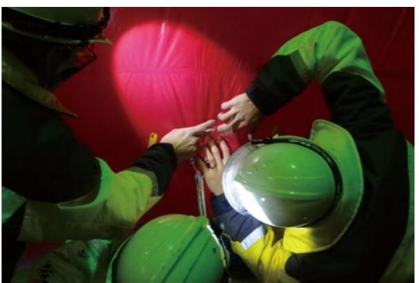
気温が低い環境で上げ下げをし、膨らんだりしぼんだりを繰り返したため、気球に亀裂が生じた。写真は気球を補修している様子。
