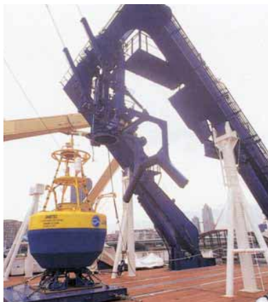
クレーンを使いトライトンパイを設置。
