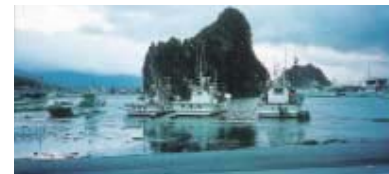
写真1 襟裳の西側の様子(さまに)漁港は、十勝沖地震の影響で22cm沈降し、岸壁を超えて海水が道路まで来ていた。
