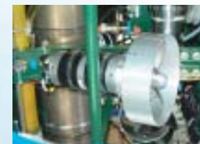
増設されたスラスター
