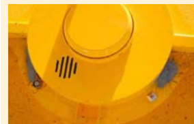
16号基の格納部外蓋は溶接された
