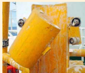
支持部が壊され温度計が盗られた跡
