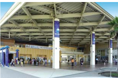
2004年4月に建物も一新してオープンした新江ノ島水族館
