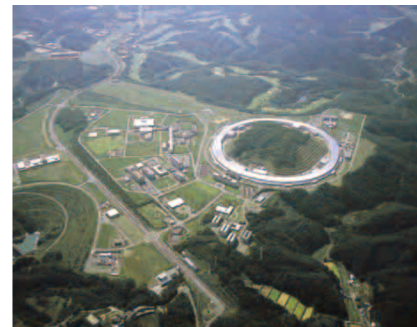
141ヘクタールの広大な敷地に設置された大型放射光施設「SPring-8」（兵庫県・佐用町）。蓄積リングの周長は世界最大の1,436m （写真提供／財団法人高輝度光科学研究センター）
