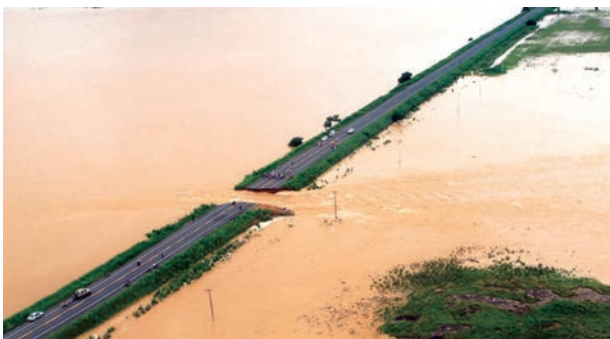
図3. 洪水によって破壊された道路。数日間に及ぶ豪雨によってリオデジャネイロ北東のMuriae川が氾濫した。(2012年1月5日)
