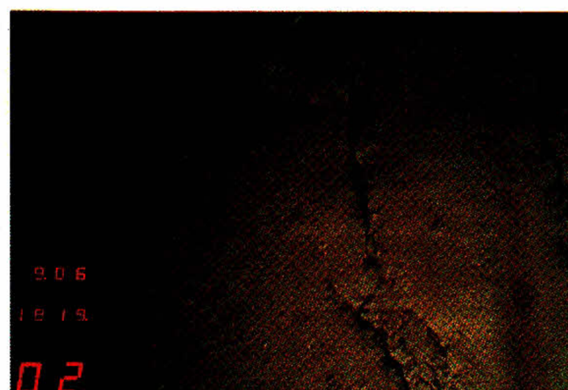
写真6 測線C-3 1 (09時06分18秒) 軟かい底質の古い地割れ (縁が丸い) C-3 1 (09:06:18) Older cracks on the soft sediments.
