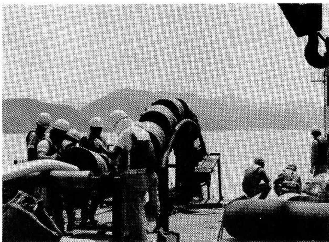
写真 1 フレキシブルライザー管敷設作業 Photo 1 Pipe lay work
