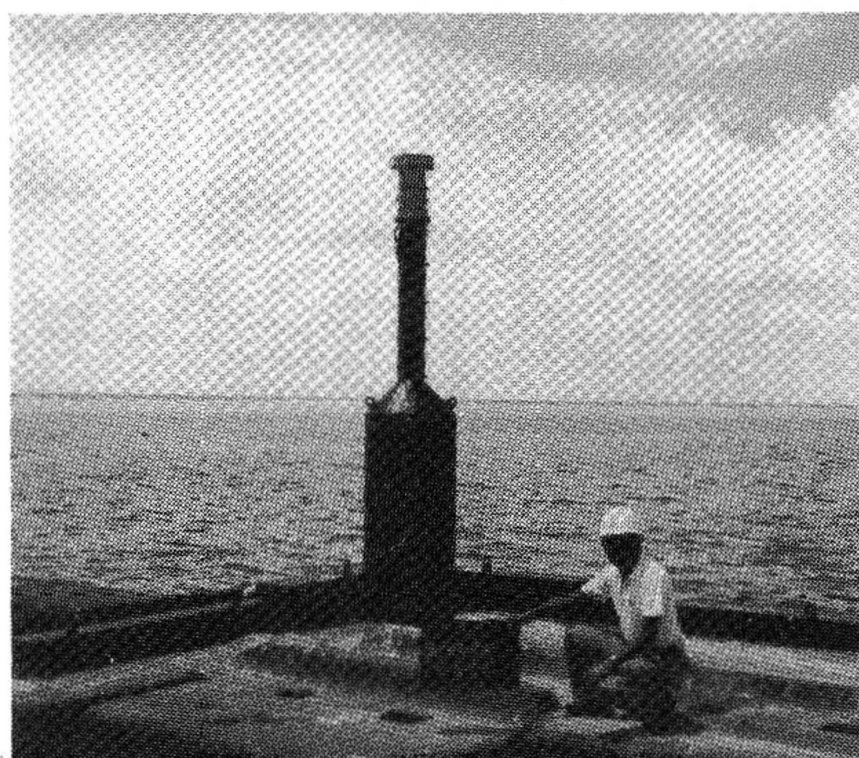
写真 2 波力発電装置取り付け状況 Photo. 2 General view of wave power generator
