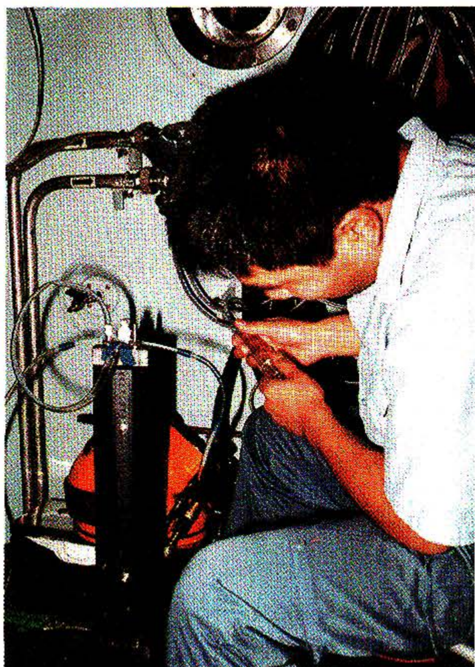
写真7 水柱マンメータを用いた差圧計の校正 Photo 7 Calibration of difference pressure transducers
