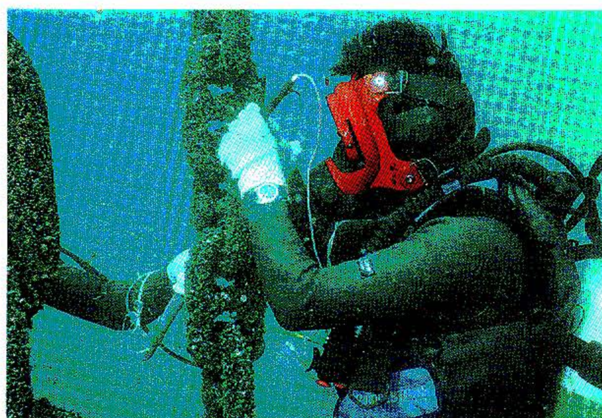
写真5 防食電位の計測
