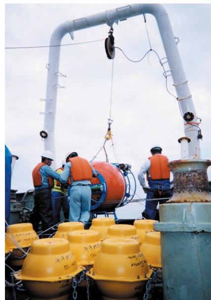
写真4 係留系設置作業(3)：係留系の投入を開始し、最初にトップブイを投入している様子。
