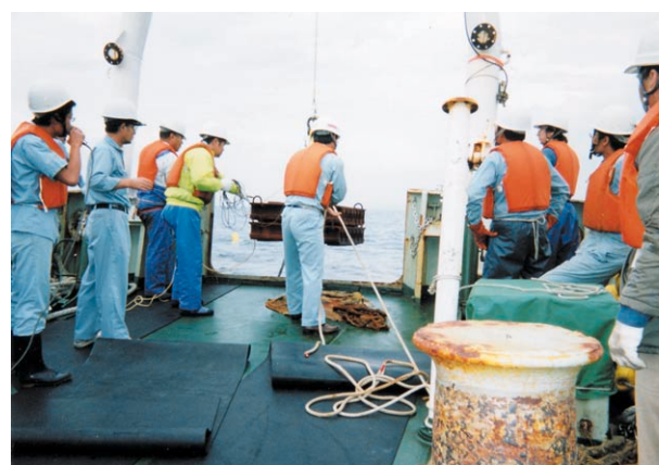
写真5 係留系設置作業(4)：係留系の最後にアンカー(重り)を投入している様子。
