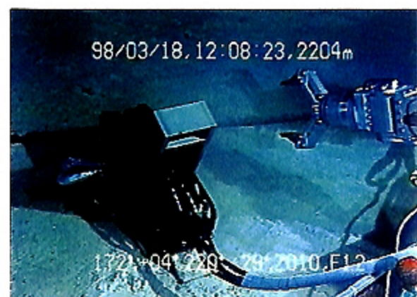
写真6 ケーブルグリップの接続作業 Photo 6 Cable Gripping Operation
